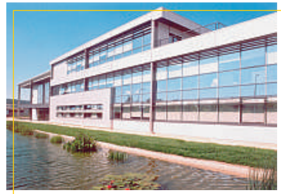
Industrie pharmaceutique, France
