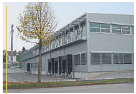
Stockage de produits pharmaceutiques, Suisse
