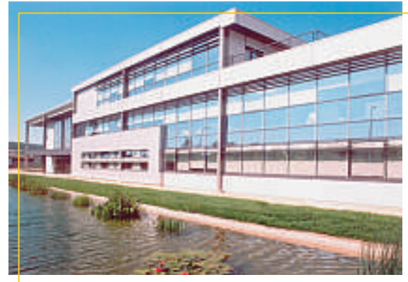
Edificio per Celle Frigorifere, Francia
